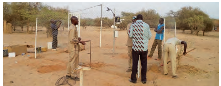
Installation d'une station météo à la Mare d'Oursi.
